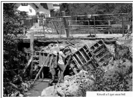
Készül a Liget utcai híd
