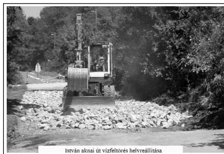
István aknai út vízfelvezetés helyreállítása
